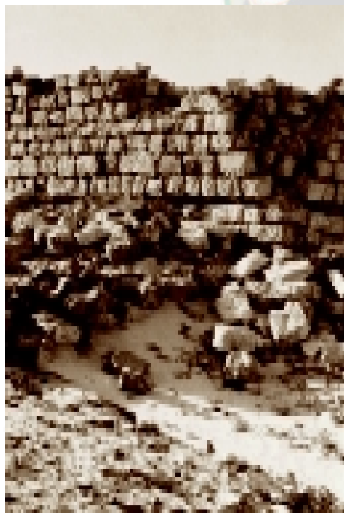
جزء من مبنى نبطي بموقع قرية
